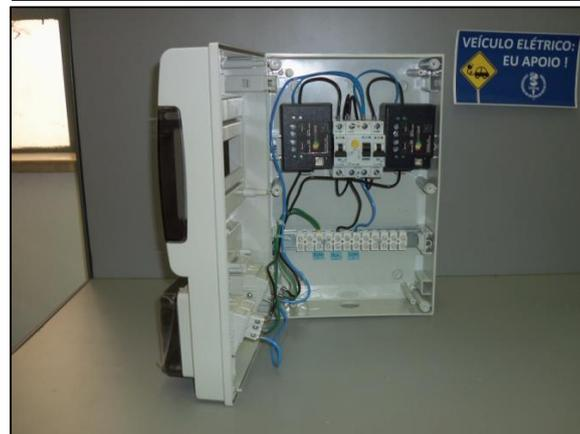
Figuras 5A e 5B. Vistas frontal e interna do painel de recarga das bicicletas elétricas
