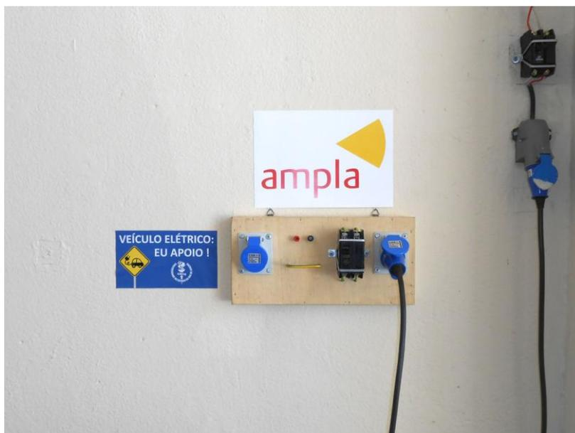
Figura 1.4. Painel de recarga, com conexões disponíveis para equipamentos de medição e aquisição de dados, conectado a rede elétrica.
