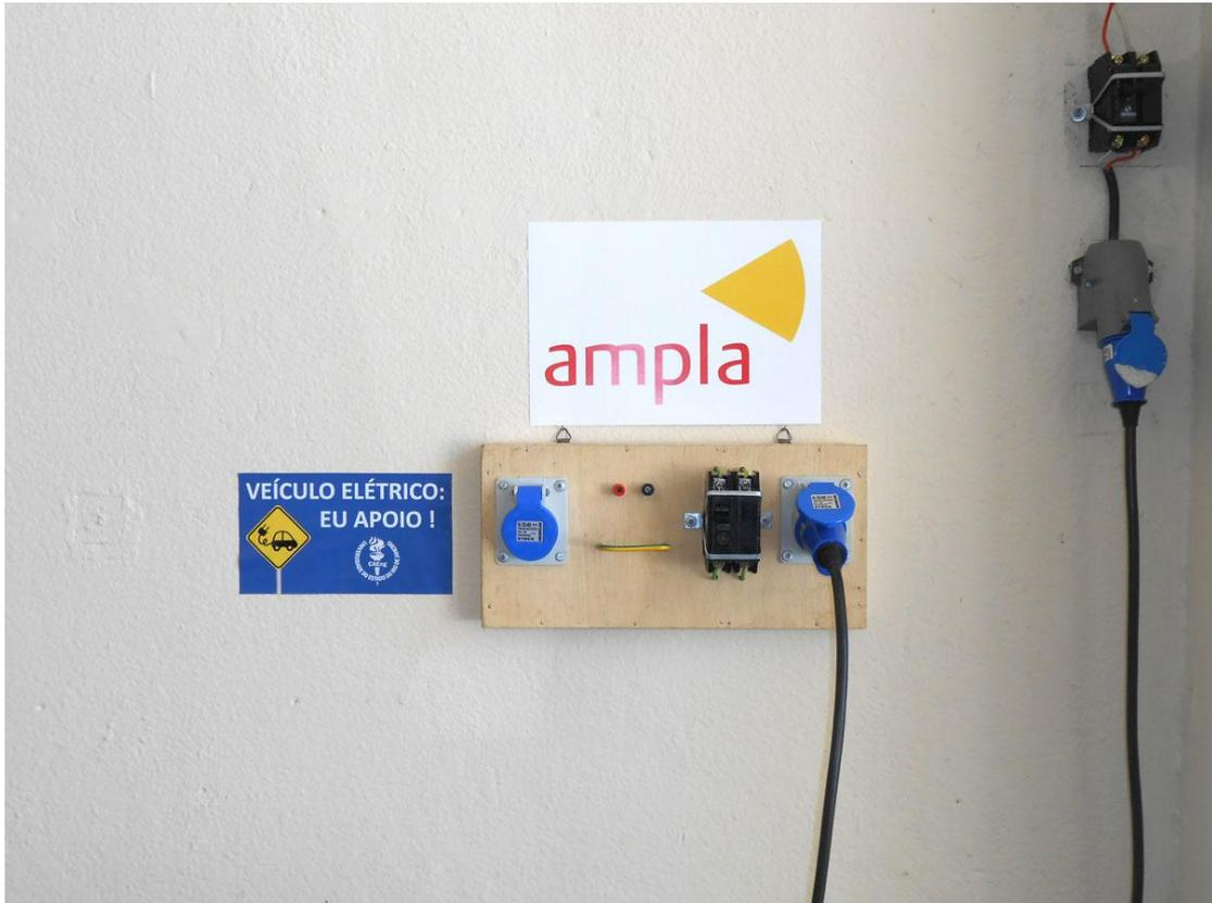
Figura 3.4. Painel de recarga, com conexões disponíveis para equipamentos de medição e aquisição de dados, conectado a rede elétrica.
