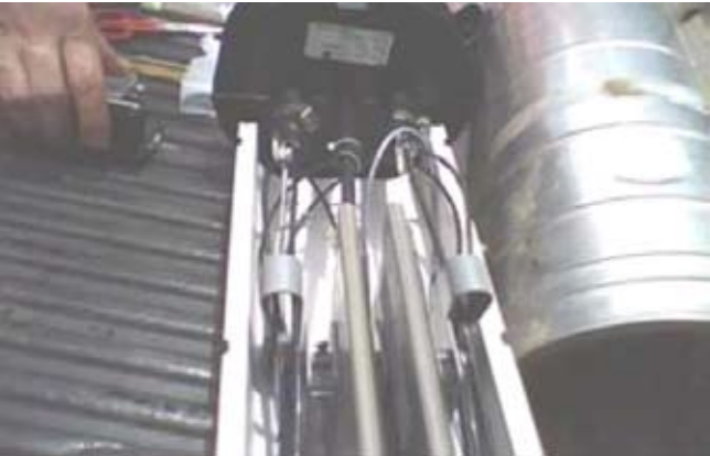
Figura 3. Adaptação de cordão óptico na caixa de emenda principal.
