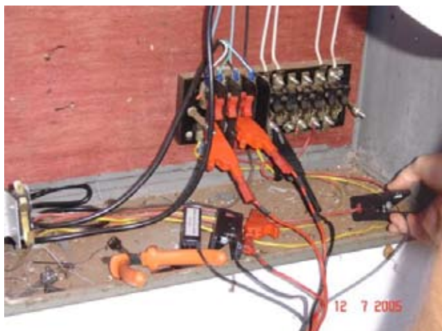
Figura 1. Técnico da concessionária realizando inspeção
