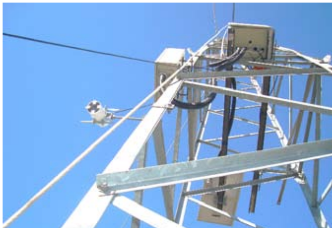
Figura 2. Detalhe da instalação do protótipo.
