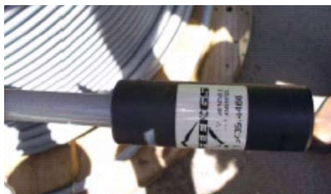
Figura 4 – Mufla Terminal para Cabo Protegido de 185 mm²
