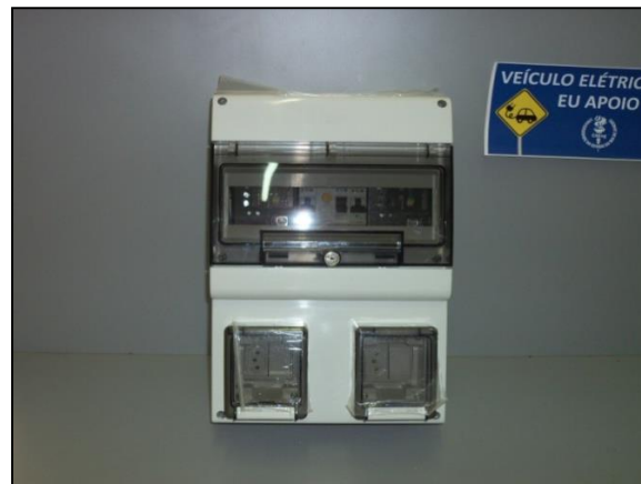
Figuras 4A e 4B. Vistas frontal e interna do painel de recarga dos carros elétricos
